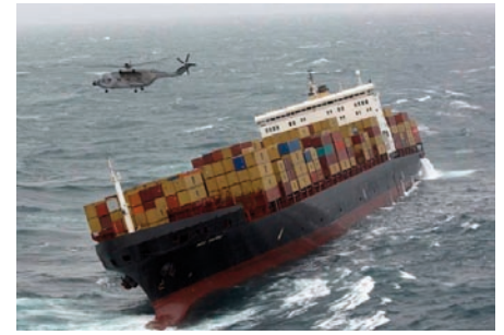
På skrovets babordssida, rakt under bryggvingen, syns tydligt en spricka. Foto: Marine Nationale.
